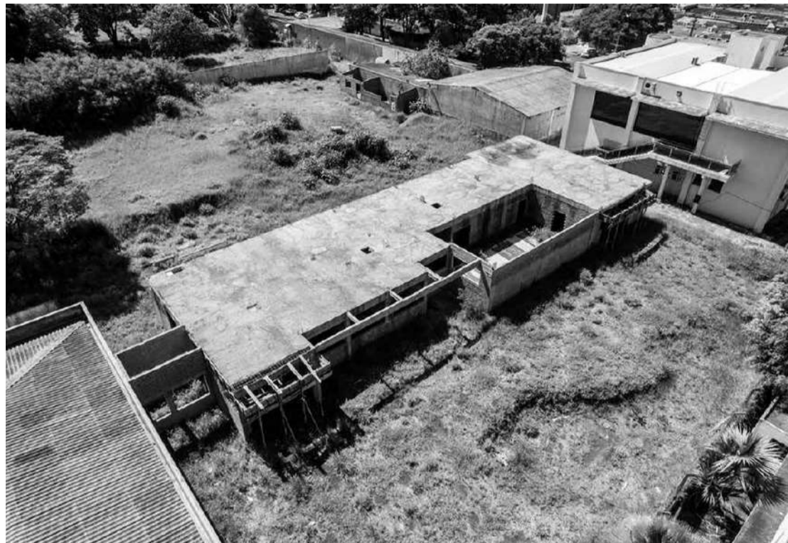
A unidade compreende uma construção térrea, com área de 464,23 m 2 , onde será prestado atendimento individual e coletivo dos pacientes que necessitam de atenção em nível terciário
