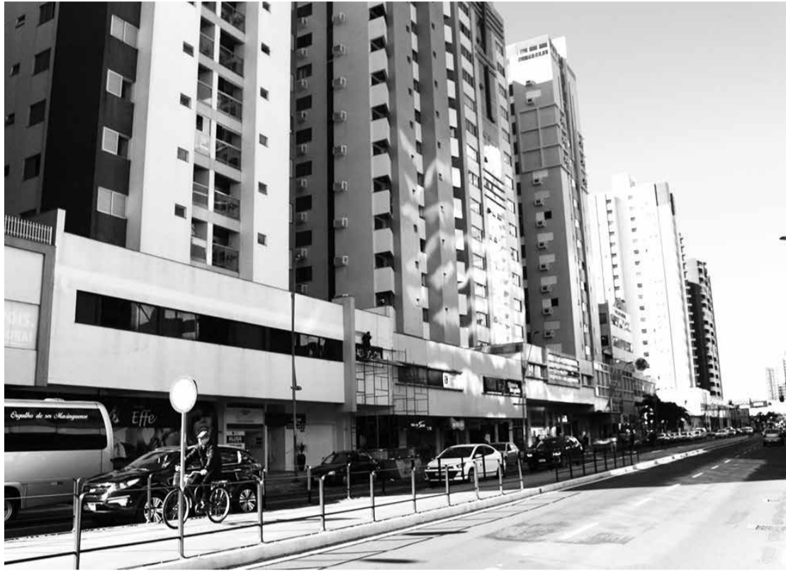
Movimentação em via pública do Novo Centro de Maringá
