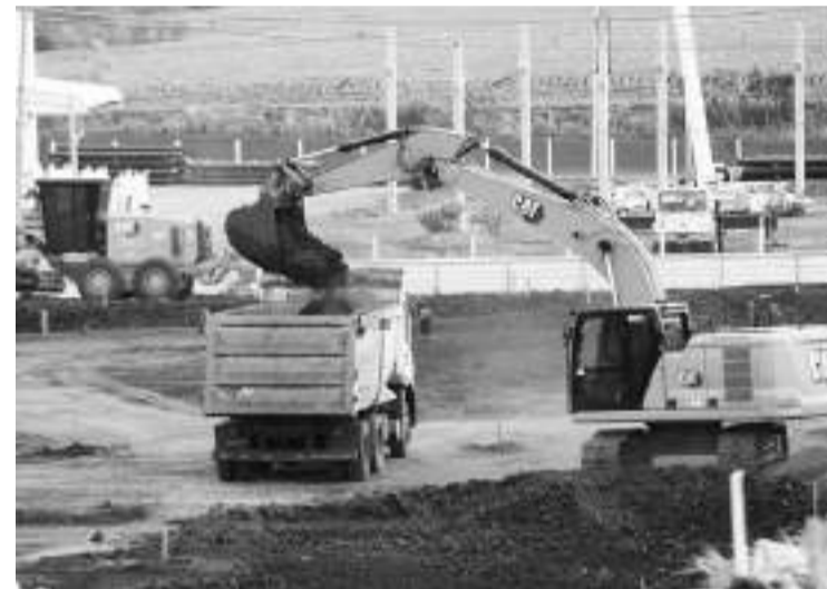
Obras do Parque Tecnológico Industrial da Saúde do Tecpar já iniciaram em Maringá
