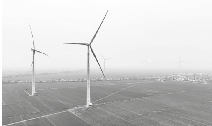
Turbinas eólicas na Ilha de Mianchuan, na cidade de Jiujiang, Província de Jiangxi, no leste da China
