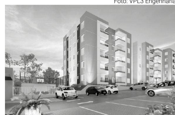
Residencial Maraús, construído em Maringá com apoio do governo do Estado, é tido como exemplo bem sucedido de moradia social
